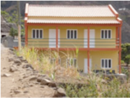
Bâtiment terminé, João Afonso.
