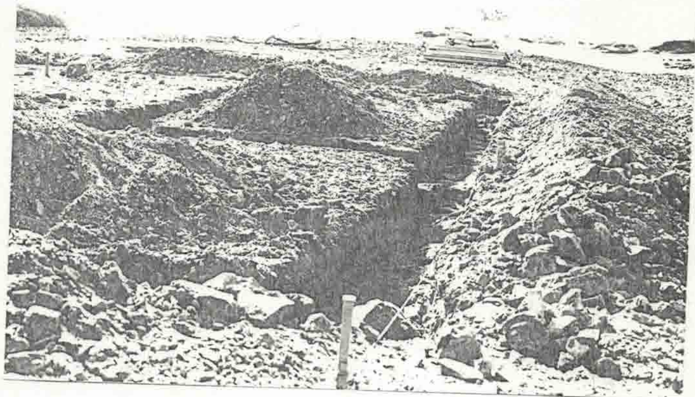
Un mois plus tard, une équipe termine les fondations
