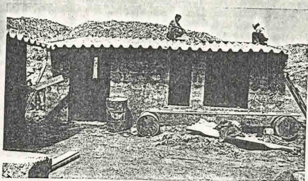
Vingt personnes ont vécu isolées pendant des semaines pour mener à bien ces constructions.
